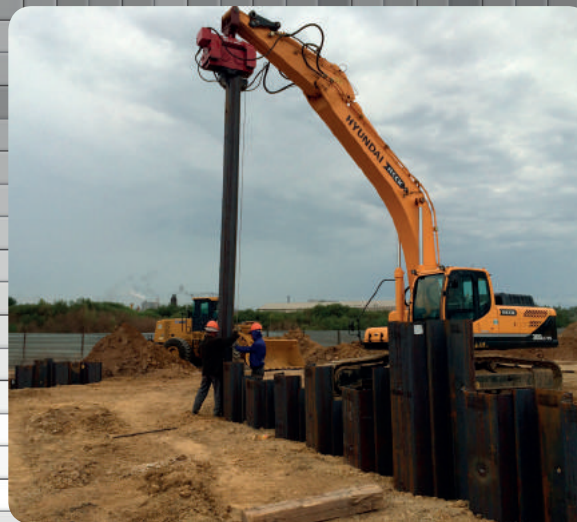
Погружения шпунтового ограждения, вибропогружателем Muller MS -4 HFB
