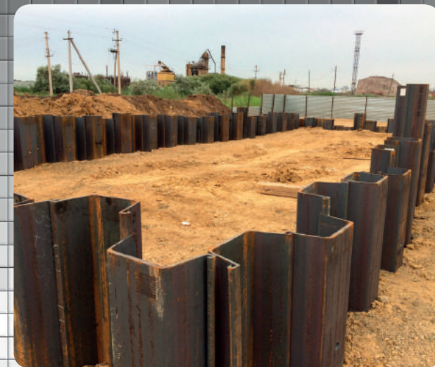
Погружения шпунтового ограждения, вибропогружателем Muller MS -4 HFB
