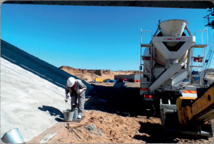
■ Проверка подвижности бетонной смеси.
